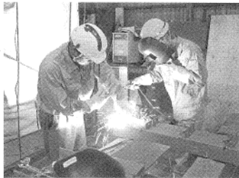
株高山鉄工所 アーク溶接
