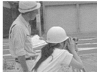
株高橋建設 水準測量
